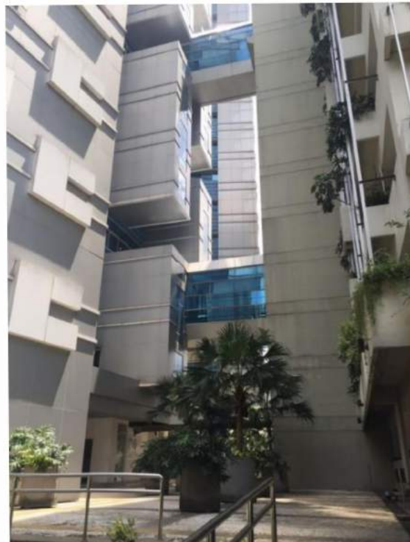
Gambar II.115. Contoh jembatan penghubung antar bangunan pada fasilitas publik (sky bridge)
